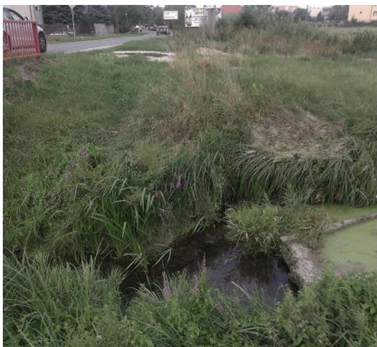
Obr.12 Vyústenie zberača VP.2 do Vajnorského potoka a zatrubnené rigoly na Roľníckej (prítok zberača VP.2)
