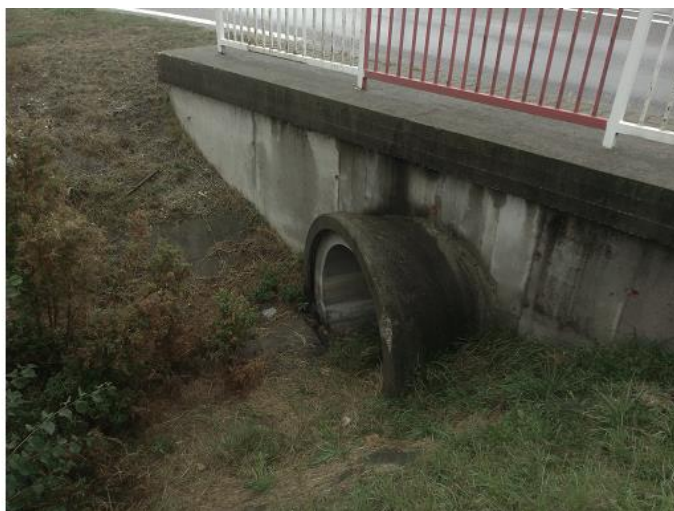
Obr.3 Kratina – pohľad od Rybničnej ulice a horný koniec priepustu DN1200 popod Rybničnú
