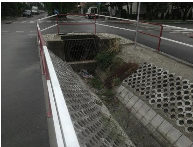
Obr.6 Vajnorský kanál – zaústenie Pračanskej – vtokový objekt s hrablicami na potrubí DN1000
