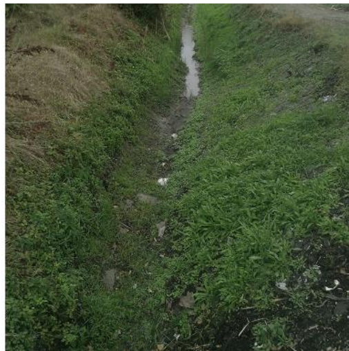
Obr.5 Vajnorský kanál – vyústenie Pračanskej DN1400 a pohľad od vyústenia smerom po toku vody (vidieť nánosy)
