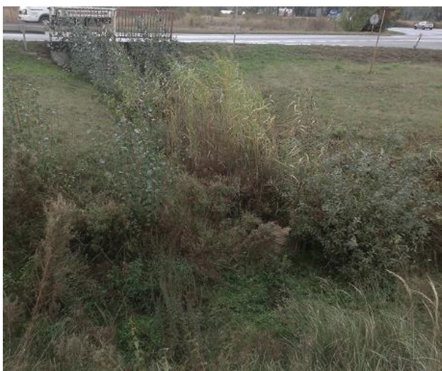
Obr.4 Kratina – priestor medzi priepustmi na Rybníchej a opevnenie vyústenia potrubí DN300 a DN400
