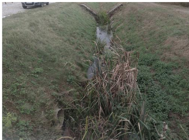
Obr.1 Kratina - vyústenie zberača KR.1 a betónový-kamenný prah
