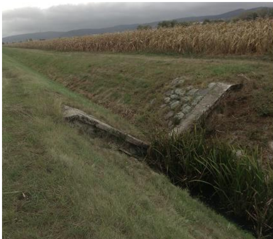
Obr.1 Kratina - vyústenie zberača KR.1 a betónový-kamenný prah
