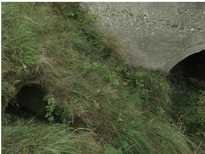
Obr.3 Kratina – pohľad od Rybničnej ulice a horný koniec priepustu DN1200 popod Rybničnú
