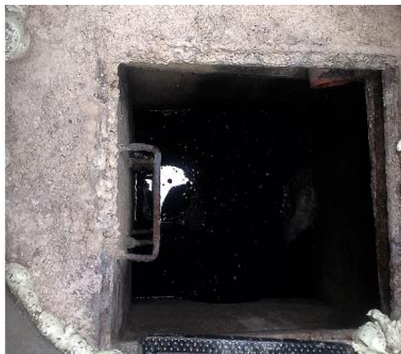
Obr.9 Zberač KR.1 – ulica Na doline, prvá šachta zberača KR.1 (protisklon)
