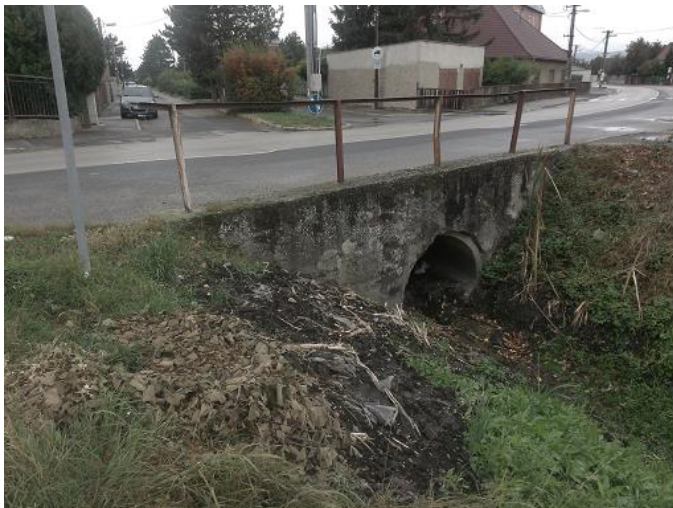
Obr.6 Vajnorský kanál – zaústenie Pračanskej – vtokový objekt s hrablicami na potrubí DN1000
