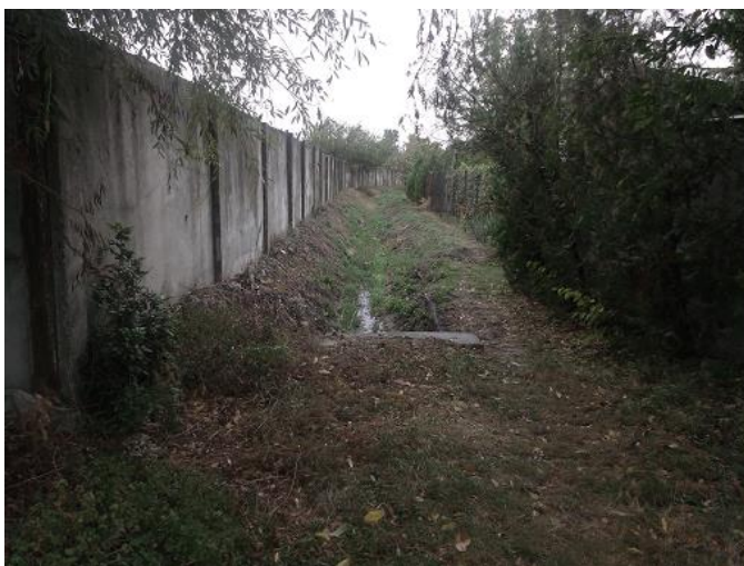
Obr.13 Kanál VK.1 – Vyústenie DN700 pri Tomanovej
