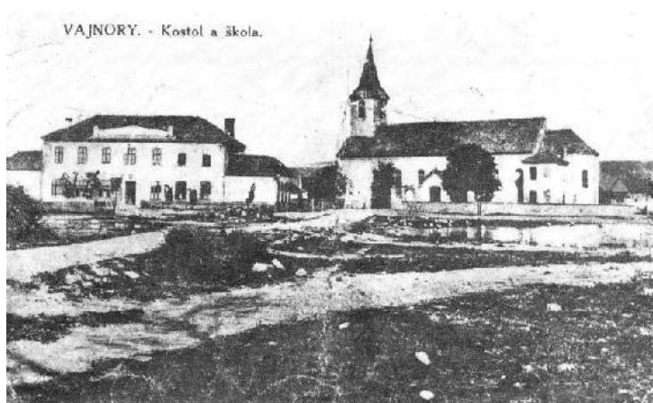
VAJNORY. - Kostol a škola. POHĽAD NA ŠKOLU A KOSTOL Z ROKU 1926, foto: T. Belaj
