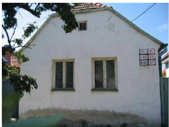
č. 93-95-97- 2 (1) štít s polvalbou a okná s prvoradým zabezpečením údržby a prípadne opravy poškodených častí.
