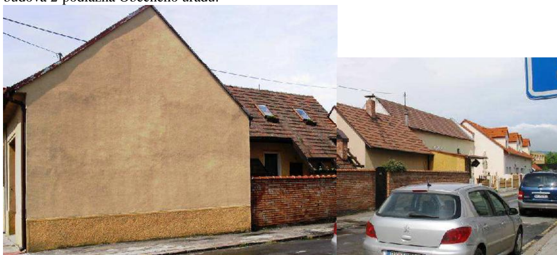
Pohľad na nárožie Jačmennej ulice s otvoreným dvorom po odstránení domov pri výstavbe Obecného úradu. Opravou dvorového krídla dom č. 101 sa modernizovala zástavba dvorového krídla, kde však na konci dom č. 7 má nevhodne použité vikiere.
