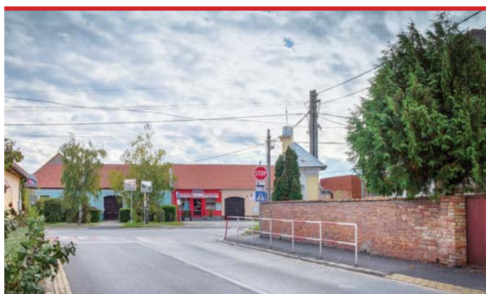
Osadené zábradlie na Rybníckej pri kaplnke.
