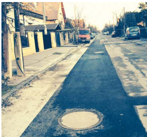
Dokončenie a kolaudácia kanalizácie
