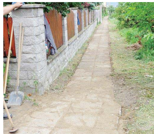
Oprava chodníka za futbalovým ihriskom - medzi ulicami Pri struže a Rolníckou na konci Vajnor.
