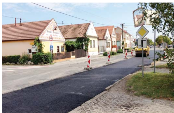
Nový asfalt na Rolníckej ulici.
