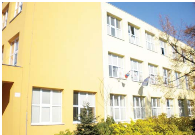
Kompletne zateplená škola Kataríny Brúderovej.
