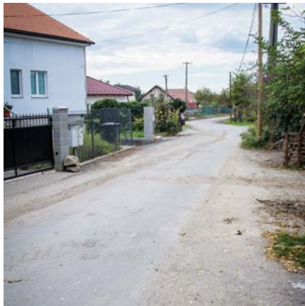
Úprava nespevnenej ulice Za humnami v spolupráci s firmou Skanska asfaltovou drťou.
