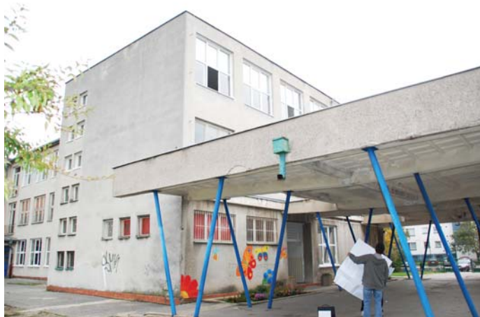
Škola sa pred zateplením nachádzala v dezolátnom stave.
