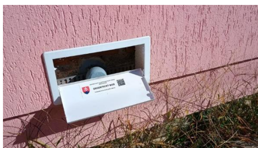
Obr. 3 Príklady vynechania výrezu: Geodetický bod môže ostať na fasáde priznaný alebo zakrytý plastovou chráničkou, prípadne kovovou mriežkou
