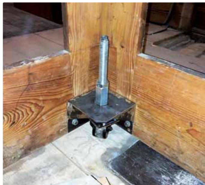
Obrázok č. 6 – kolieska so zdvihom, ktoré slúžili na presun organovej skrine
