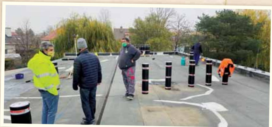
Oprava strechy na seniordome
