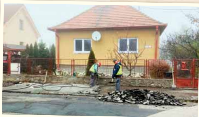
Oprava chodníka na Zátureckého
